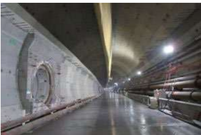
TM-CLKL: Cross Passage Construction
