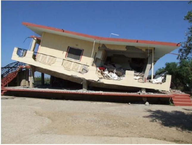
Κατάρρευση κτιρίου από ωπλισμένο σκυρόδεμα (κατασκευής 1983-1984) στα Άνω Διδαχαίικα
