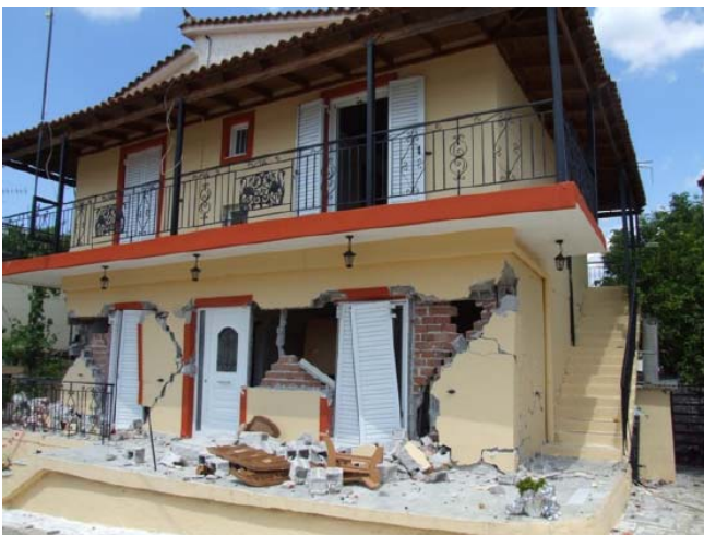
Σημαντικές βλάβες σε διώροφο κτίριο από φέρουσα τοιχοποιία στη Φώσταινα
