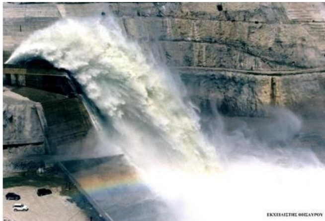
Κάδος Αναπήδησης Εκχειλιστή ΥΗΕ Θησαυρού σε λειτουργία. Σύγκριση με αυτοκίνητα στο κάτω διάζωμα.
