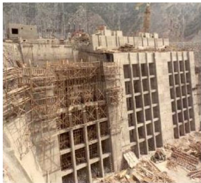
Υδροληψίες ΥΗΣ Σφηκιάς (περίοδος κατασκευής)
