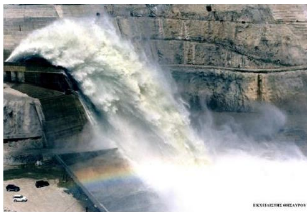
Κάδος Αναπήδησης Εκχειλιστή ΥΗΕ Θησαυρού σε λειτουργία. Σύγκριση με αυτοκίνητα στο κάτω διάζωμα.
