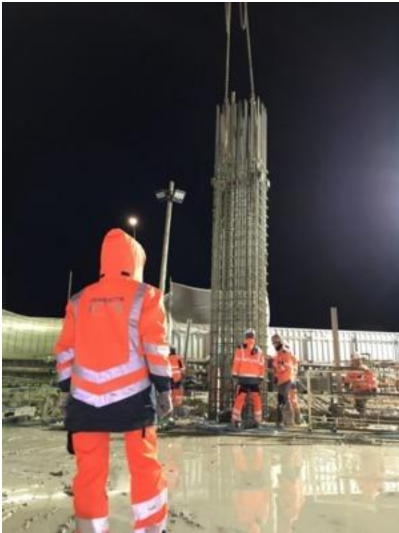
Photographie de l'équipement d'une paroi moulée.
