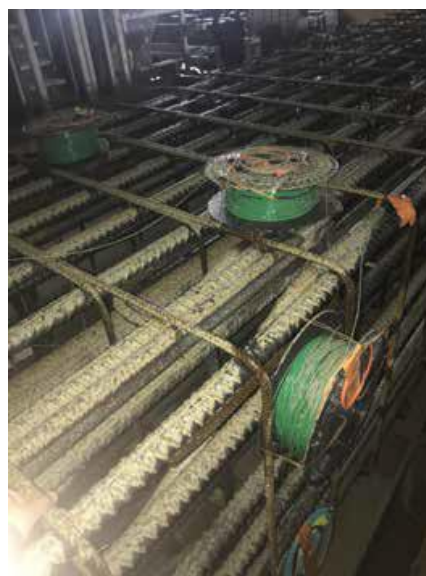
Photographie de l'instrumentation d'une cage d'armature de paroi moulée.
