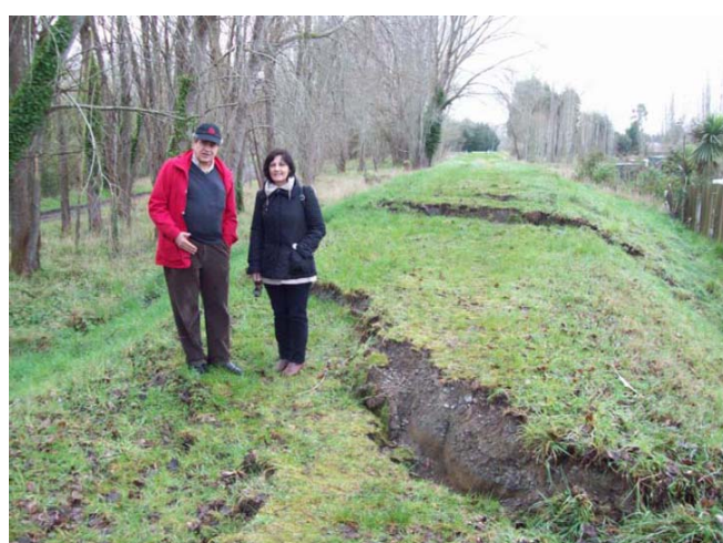
Εικόνα 21. Εγκάρσιες ρωγμές σε αναχώματα λόγω ρευστο- ποίησης και πλευρικής εξάπλωσης, κοντά στον ποταμό Waimakariri
