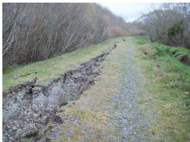
Εικόνα 20. Επιμήκειες ρωγμές σε αναχώματα λόγω πλευρικής εξάπλωσης στις όχθες του ποταμού Waimakariri
