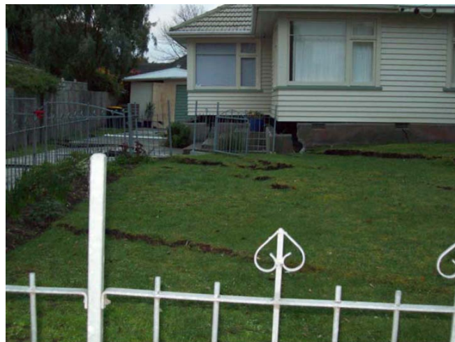
Εικόνα 19. Καταστροφές σε οικία λόγω της «άφιξης» των ρωγμών και πλευρικής εξάπλωσης (lateral spreading)
