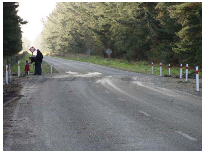
Εικόνα 10. Οριζόντια μετατόπιση δρόμου στη διέλευση του ρήγματος
