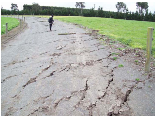
Εικόνα 13. Η ζώνη της εδαφικής παραμόρφωσης στην επιφανειακή εκδήλωση του σεισμικού ρήγματος που διασχίζει δρόμο
