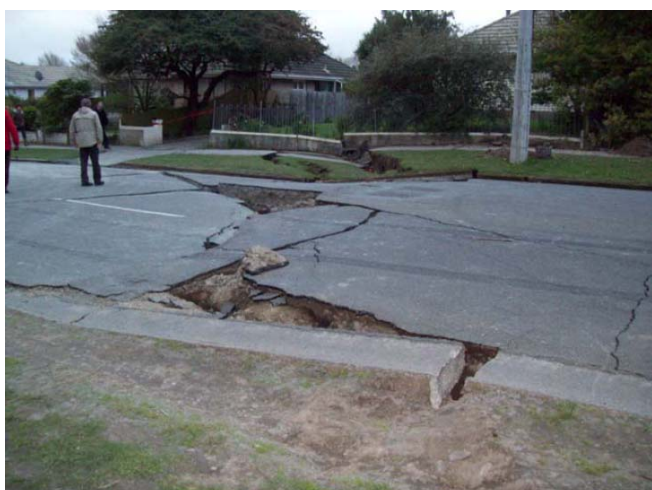
Εικόνα 18. Βλάβες στο οδόστρωμα λόγω των φαινομένων ρευστοποίησης και πλευρικής εξάπλωσης
