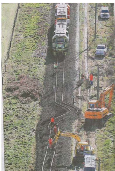
Εικόνα 23. Χαρακτηριστική παραμόρφωση (λύγιση) των σιδηροδρομικών γραμμών
