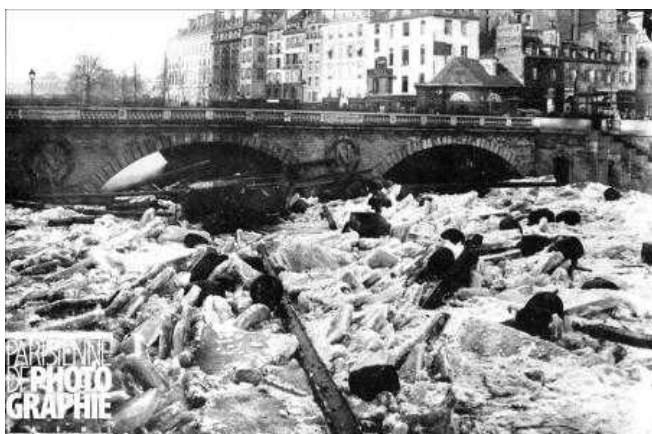
1899 Congélation artificielle de la Seine pour creusement et enfouissement d'un caisson
