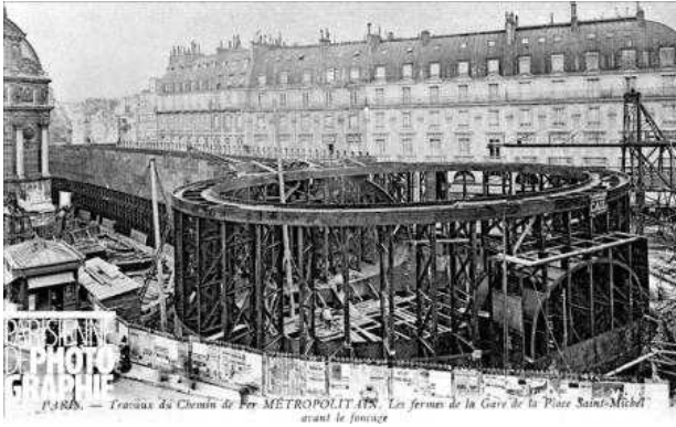
1900-1905 Préparation du coffrage pour la station St-Michel
