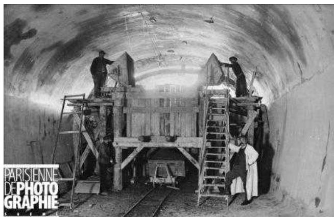
1905 Ligne n° 4, enlèvement de la terre et des gravois
