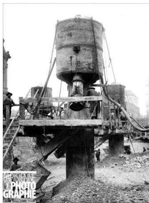
1907 Sac à air permettant aux ouvriers souterrains de respirer
