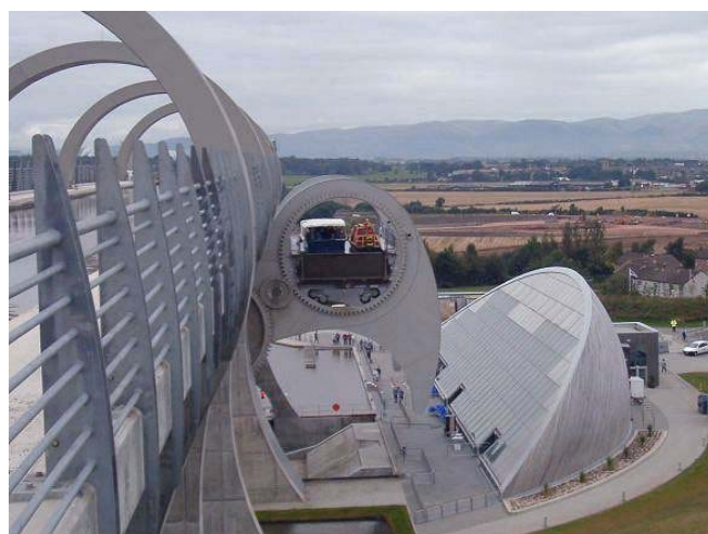
En cours de rotation, chaque nacelle doit être maintenue horizontale par un jeu d'engrenages
