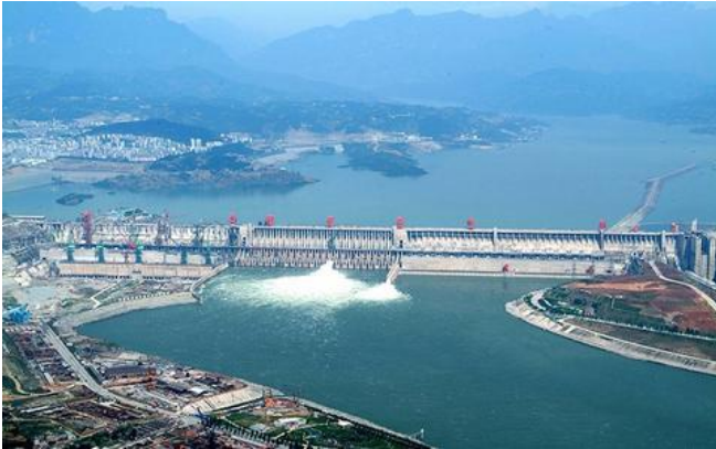
Φράγμα των Τριών Φαραγγιών, Κίνα (22 δισ. δολάρια) Το μεγαλύτερο υδροηλεκτρικό φράγμα του κόσμου στον ποταμό Γιανγκτσέ της Κίνας με ύψος 180 μέτρων και μήκος 2.335 μέτρων.
