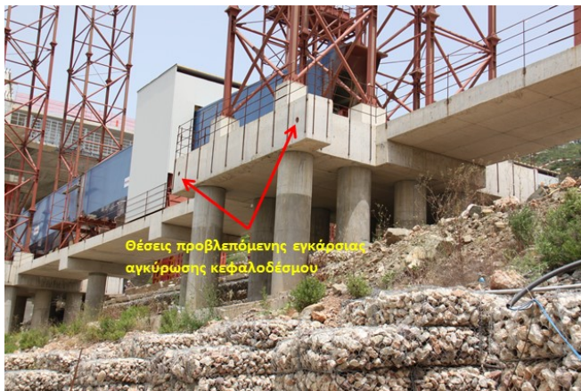
Εικόνα 5. Θέσεις προβλεπόμενης εγκάρσιας αγκύρωσης κεφαλοδέσμου Π2Δ
