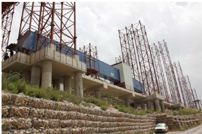
Εικόνα 3. Θεμελίωση πύργων ανέγερσης και διάδρομοι / γέφυρες συναρμολόγησης τόξου δεξιού κλάδου
