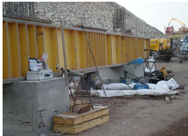
Εικόνα 4. Δοκιμαστική φόρτιση πασσάλων
